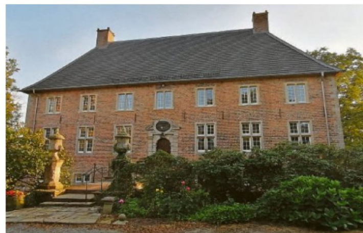
Erster Preis: das „Haus Horst“ (Nordseite) der Familie Wolfering in Heek-Ahle, Adelssitz seit 1674 und zuletzt sechs Jahre lang restauriert.
